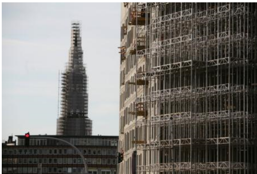
Blick auf den eingerüsteten Turm von St. Katharinen (l.). Foto: Michael Rauhe
